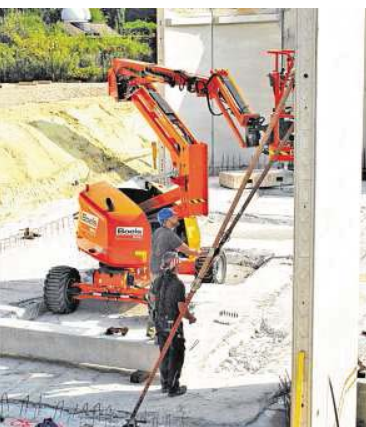
Polier Markus Bierbach bringt die Wandelemente mit Stützen ins Lot (links). Im schon bestehenden Wasserwerk Wallhöfen lagern 1,5 Kubikmeter Trinkwasser in verschiedenen Wasserbehältern.
