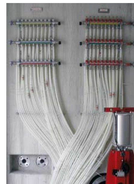
Heizkreisverteiler
